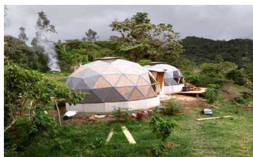
Formas bioconstructivas. Ama Gi. Fuente: Ecomunidadamagi.
