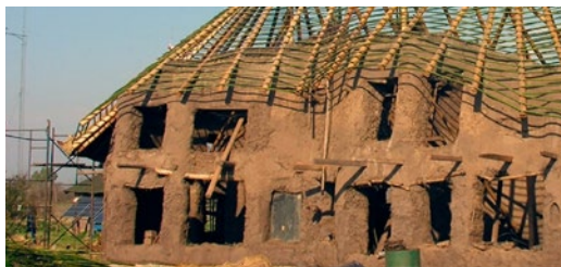
Construcción en Ecovilla Gaia. Fuente: Asociación Gaia.
